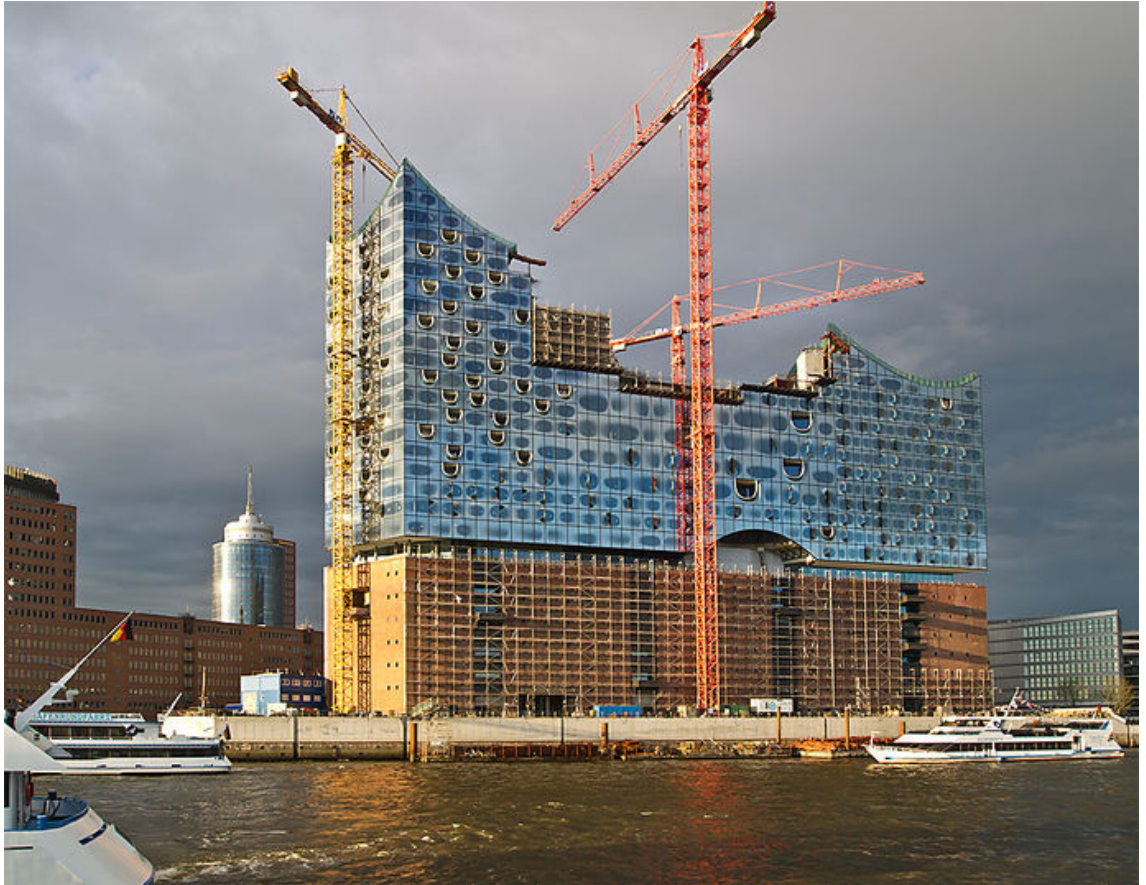
15: Будівельний майданчик Ельбської філармонії в Гамбурзі у травні 2013 року (фото: Pedelecs https://creativecommons.org/licenses/by-sa/3.0/deed.en CC BY_SA 3.0; Wikimedia)
