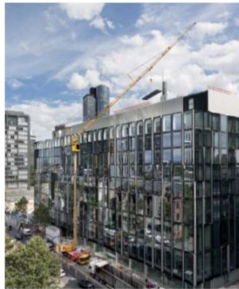
Mit seinem geringen Platzbedarf konnte der Mobilbaukran in nur 9,5 m Abstand zum Gebäude montiert werden. So musste die Straße nur halb abgesperrt werden. (Foto: Liebherr)
