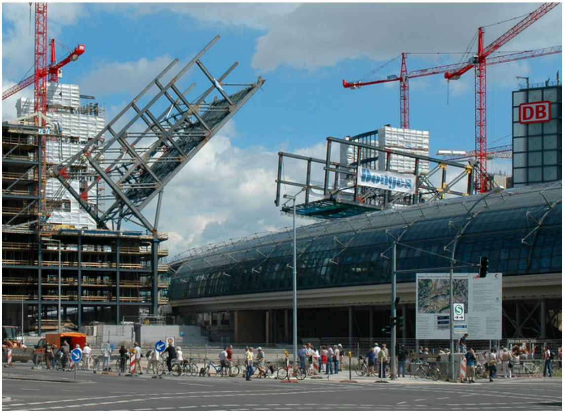
■ : „Центральний вокзал у Берліні – опускання двох половин західного мосту-скоби під час будівництва“
